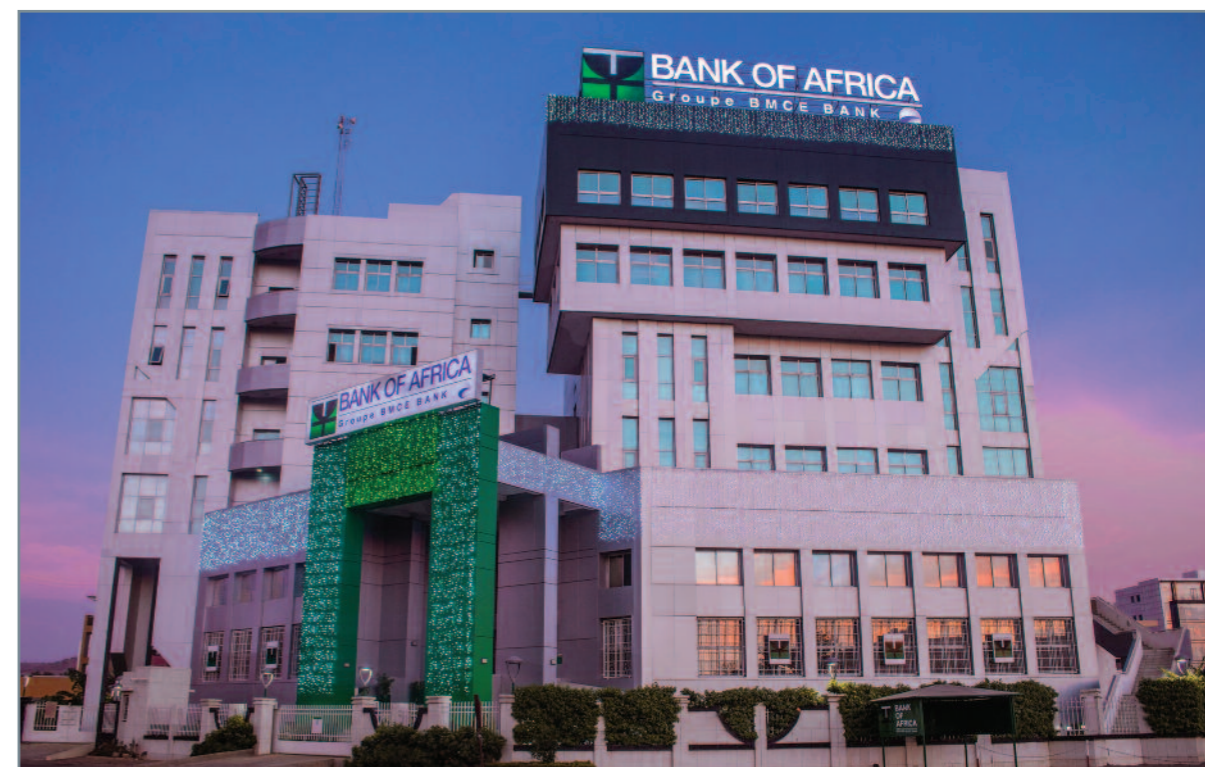
Inauguration du nouveau siège BOA-MALI
