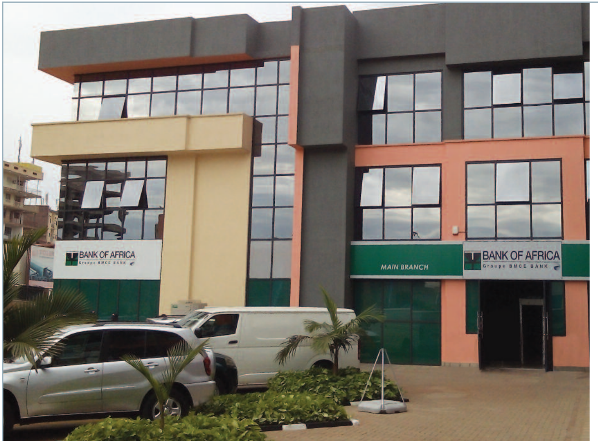
L'Agence Principale à Kigali au Rwanda
