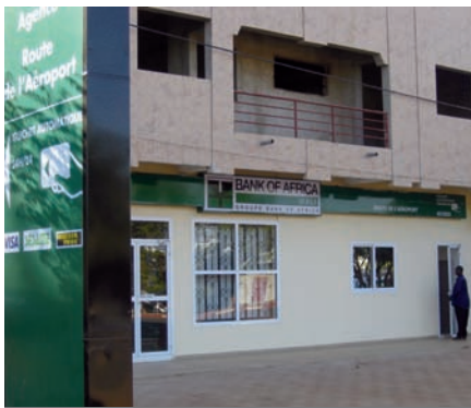
L'Agence Route de l'Aéroport, à Bamako. The "Route de l'Aéroport" Branch, in Bamako. © BOA-MALI
